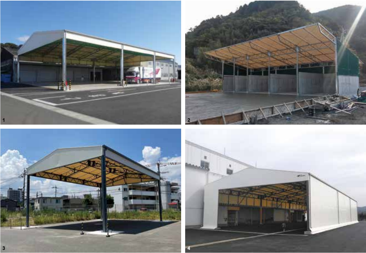
1. JA 高岡。2. 雨に濡れないよう前面に大きな庇を設けています。3. ガルウイング仕様のトラックに対応するため軒高を6.5mにし、間柱を無くしました。4. 工場隣接のため不燃膜材を使用し、鳥害対策用に防鳥ネットも取り付けられています。
