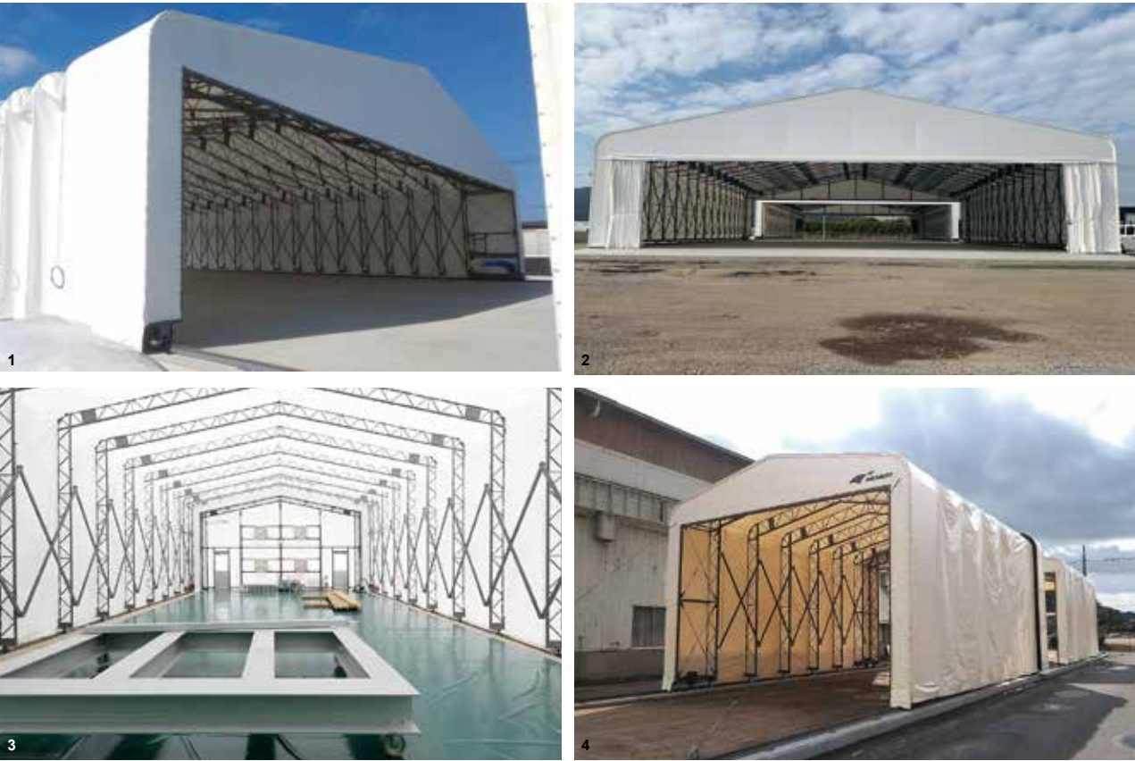
1. 2. 伸縮式テント倉庫：海沿いで風が強い場所でのクレーンによる荷物の出し入れ用として、伸縮式仕様を採用しました。3. 伸縮式テントの内部の様子。4. 伸縮式テント：物資の搬入出を行うことから、伸縮式テントをご提案させていただきました。
