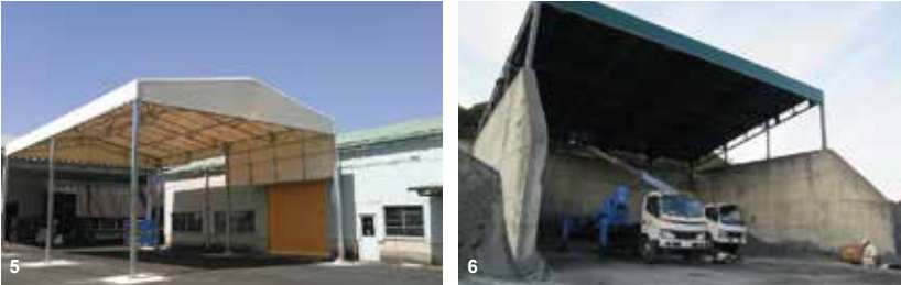
5. テント上屋：不燃膜の表面をフッ素コーティングしており、通常より防汚効果があります。6. テント屋根：既存のコンクリートの仕切り壁の歪みも、1本1本の梁の長さを変えて既存の寸法に合うよう設計・施工しました。
