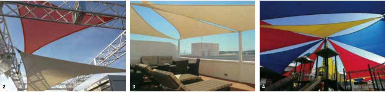
1.神奈川県のホテルのシェードセイル:シェードセイルは、三角でも四角でも、形と色の組み合わせは自由です。四角形のハイパー形(Hyperbolic)は構造的に安定し、えぐり(曲線)は日よけの「プラスα」になります。2.自社ブース参考写真。3.4.海外事例
