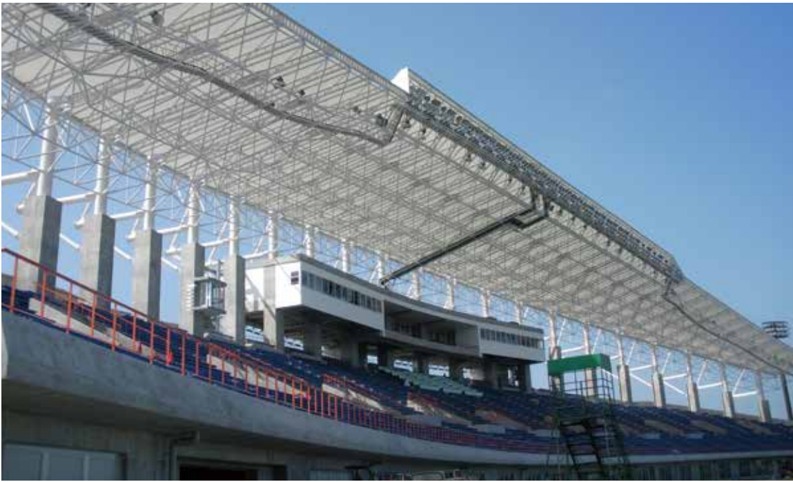
茨城県にある水戸市立陸上競技場。
