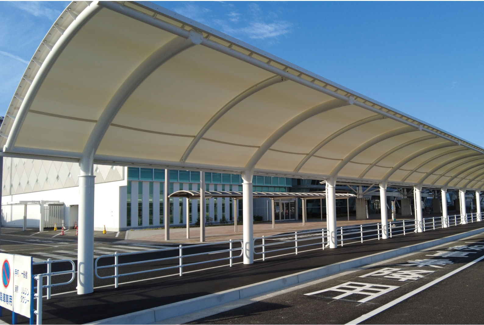
空港の利用者が車から乗り降りするスペースに設置した膜屋根。透光性の高い膜材が自然光をソフトな拡散光に変え、均質で心地よい空間を実現しています。
