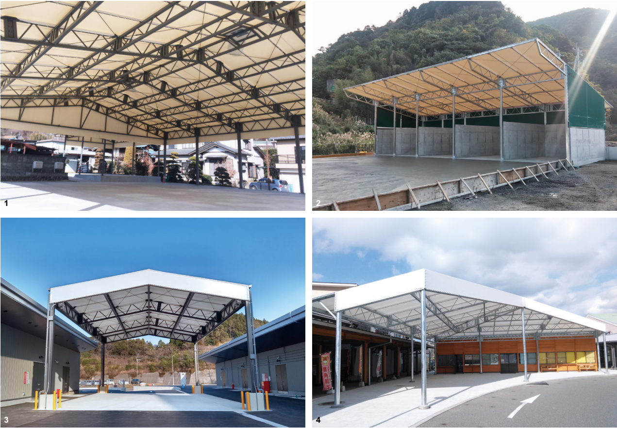
1. 風通しも良く雨に濡れない作業環境を実現した上屋。2. バイオマス施設のハイヤチップの保管を目的とした上屋。3. ウイング車のウイングを上げた状態で、屋根下での荷物の積み下ろしが出来る高さを確保。4. 道の駅の通路に強い日差しや雨を避ける空間を実現。
