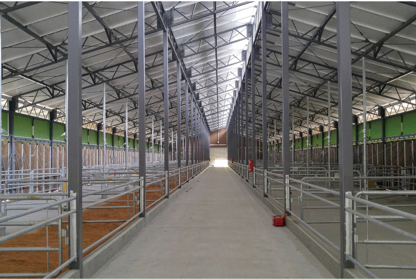
膜素材は耐薬品性（耐アンモニア）にも優れており、屋根膜は、繁殖・肥育等の牛舎の用途により高透光膜と遮光膜から機能を選べます。
