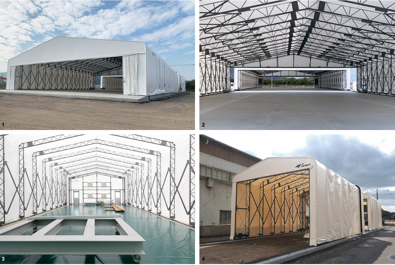
1. 2. 伸縮式テント倉庫：限られたスペースでのクレーンによる荷物の出し入れ用として、伸縮式仕様を採用しました。3. 伸縮式テントの内部の様子。4. 伸縮式テント：物資の搬入出を行うことから、伸縮式テントをご提案させていただきました。
