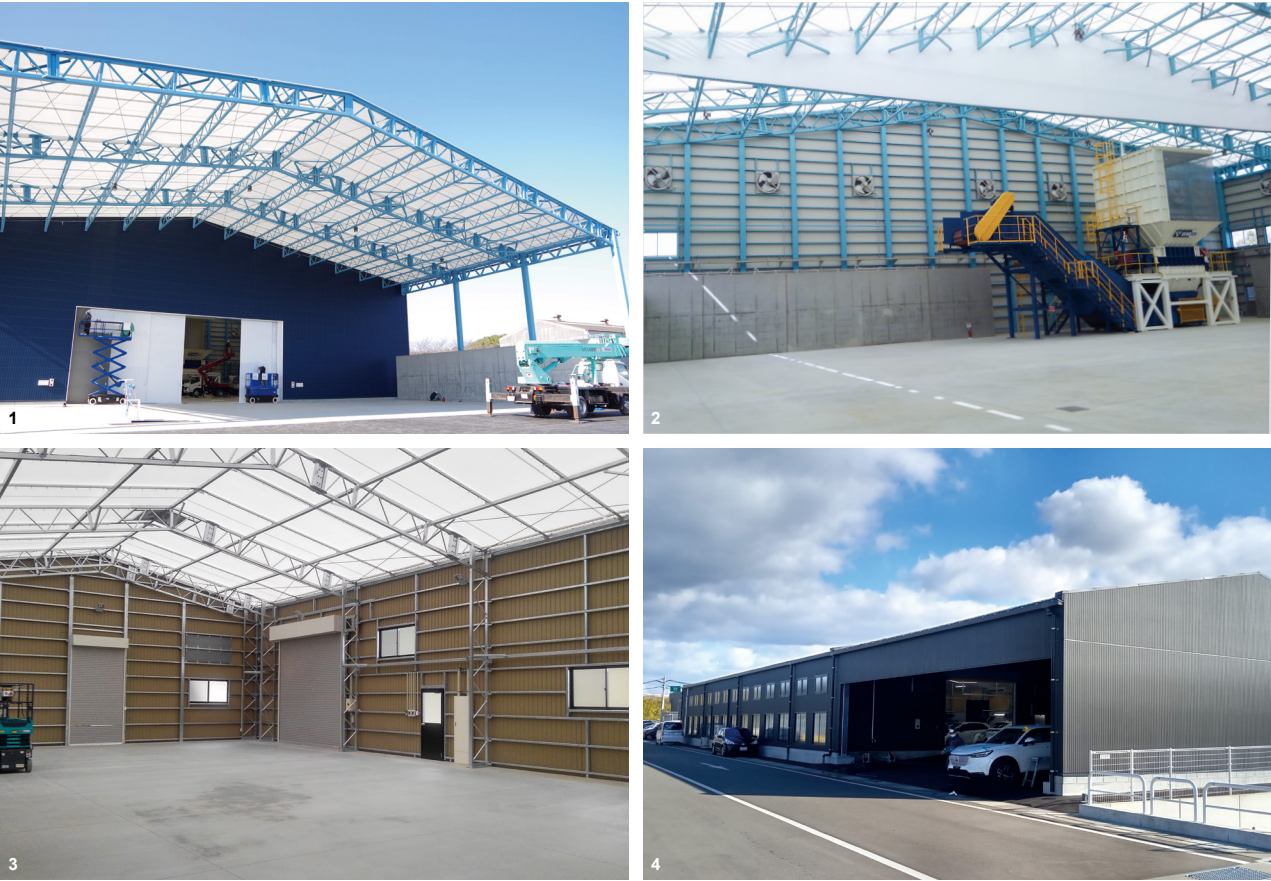
1.2. ハイブリッド膜構造：外壁を鋼板製、屋根には透光率の高い膜素材を使用して採光性を確保。3. 自社倉庫：屋根に透光率19%の膜材を使用し、壁はガルバリウム鋼板にて施工。4. 車点検場：壁は金属系サイディング、屋根に膜素材を使用。
