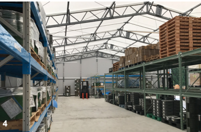
4. 資材のストックヤード：テント倉庫は内部に柱が無いので自由度が高く、高さも軒高5mの設計で大量の保管が可能です。5. トラック中継場テント倉庫：作業の際に雨に濡れないよう、出幅3.45mの大きな庇を付けました。
