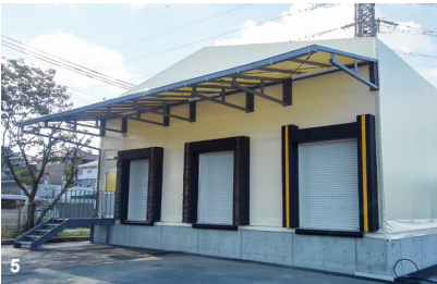
4. 資材のストックヤード：テント倉庫は内部に柱が無いので自由度が高く、高さも軒高5mの設計で大量の保管が可能です。5. トラック中継場テント倉庫：作業の際に雨に濡れないよう、出幅3.45mの大きな庇を付けました。
