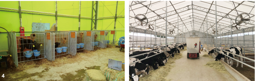
4. 膜構造畜舎は、用途によって膜素材を変更でき機能的です。5. 牛舎は、取り扱う牛の種類によって、遮光と採光のどちらを選択するか悩ましいものですが、透光率の違う膜素材を使用することでその悩みを解消します。
