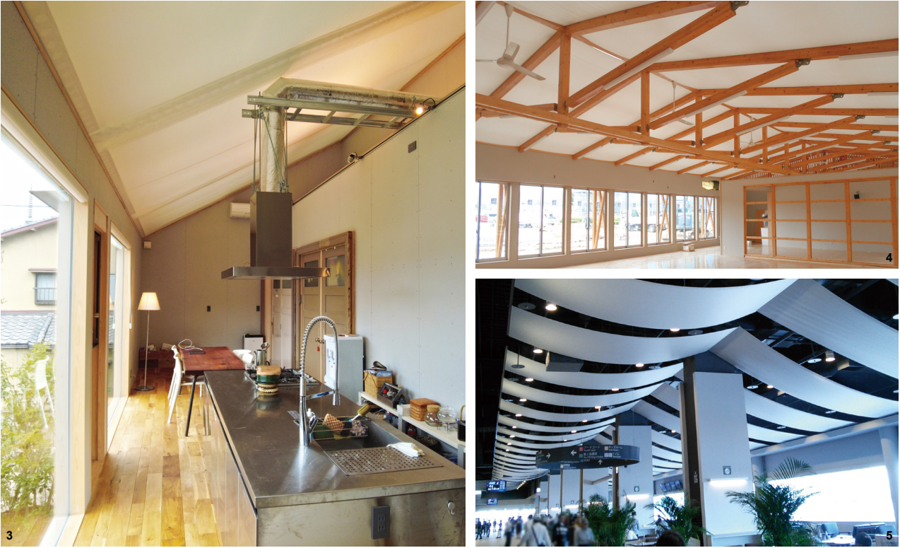
1. イーアス春日井の膜天井。2. 八王子市のショッピングセンター：天井材の軽量化と災害時の天井脱落被害の軽減を図ると共に、曲面表現による空間演出が可能です。3. 住居スペースの膜天井：家族が集う空間に、あたたかな陽射しをもたらします。4. 茨城県の健康増進施設の屋根：膜材と鉄骨や木などの組み合わせでデザインの可能性が広がります。5. 競艇場の膜天井。
