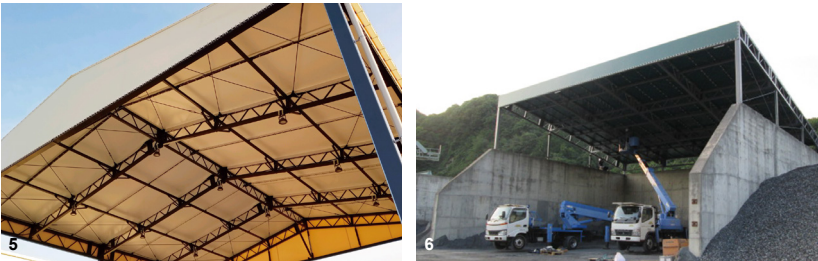
5. 敷地配置のレイアウトも自由な上屋型の荷捌き場。6. 採石場で砂・砂利を出来るだけ雨水にさらしたくないとの要望に対し、既存のコンクリートの仕切り壁の上にフレームを組んで、テント上屋を設置。
