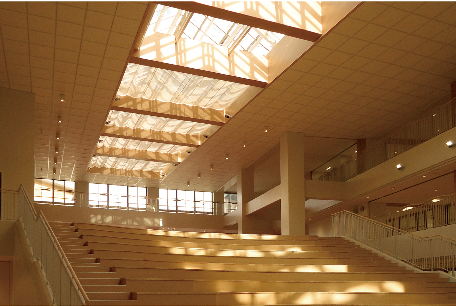
玄海町小中学校体育館：天井窓から直射日光を取り込み、膜素材を通して拡散させることで、ストレスを感じない自然な明るさに包まれる居心地の良い空間を実現します。
