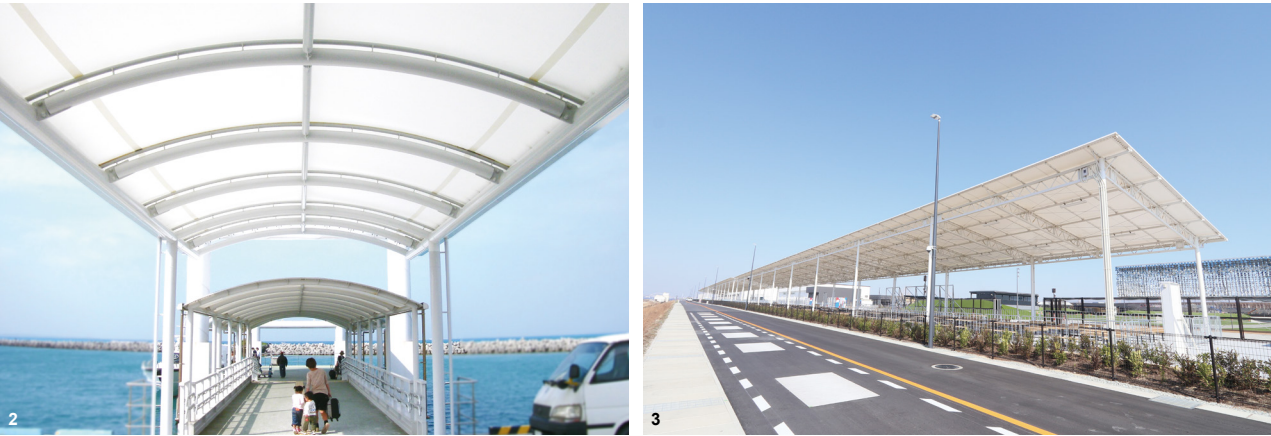
1. 阿倍野ハルカス交差点膜構造シェルター：耐久性を重視して、四フッ化エチレン樹脂をコーティングした膜素材を使用しています。 2. 小浜港通路シェルター。3. 大阪・関西万博での団体休憩スペースの大屋根。広い空間を柱なしで覆えるため、開放感と快適性を両立し、来場者の憩いの場に最適な環境を提供しました。
