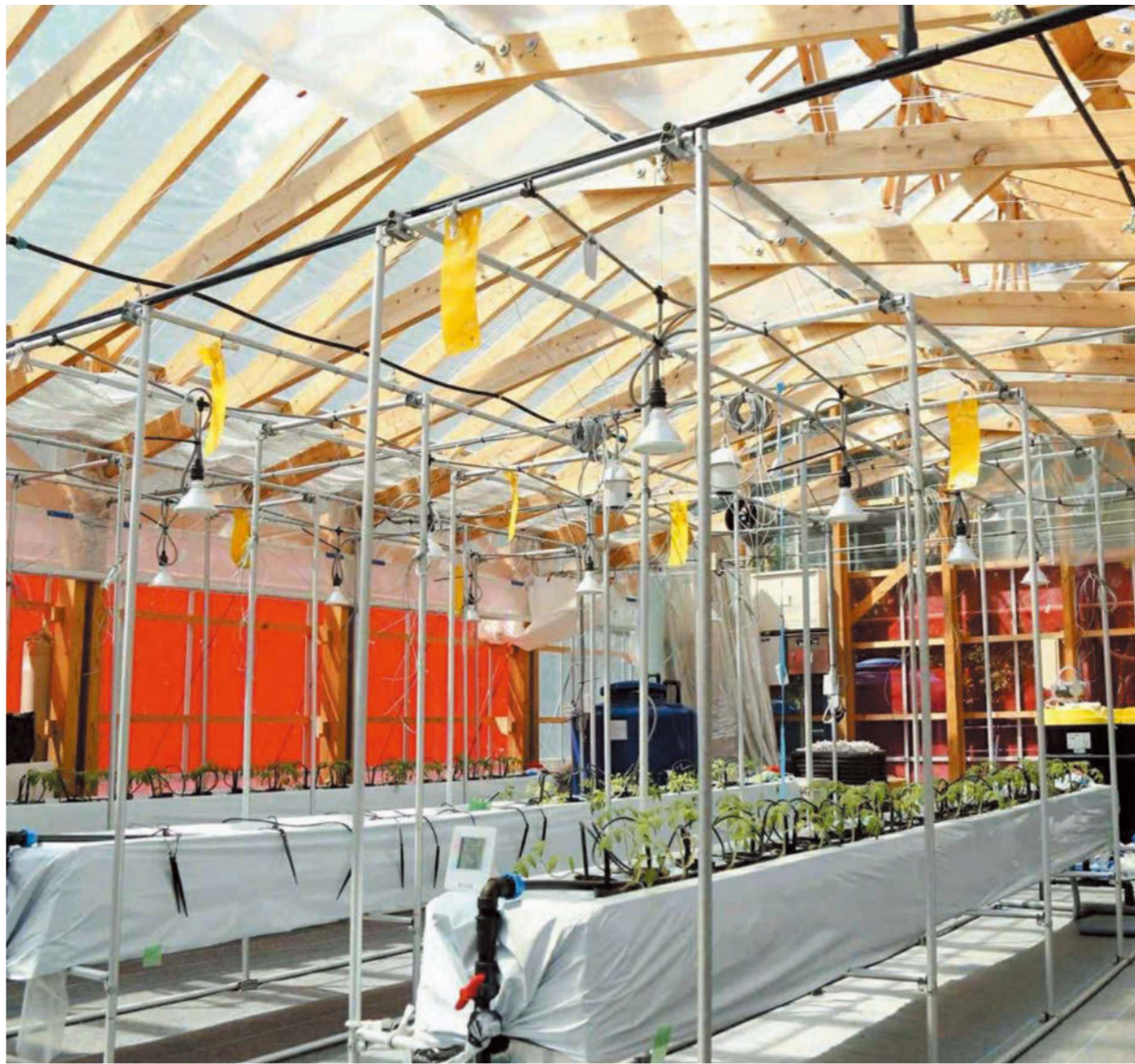
cultivera と XENCE がコラボして制作したサーキュラー木造温室。地域の未利用木材を元に開発したモジュールで作られており、地域の森林資源活性化や食糧自給率向上へ向けた試みでもある。 Photo by Morio - Skyscrapers of Shinjuku 2009 January.jpg / CC BY-SA 3.0
