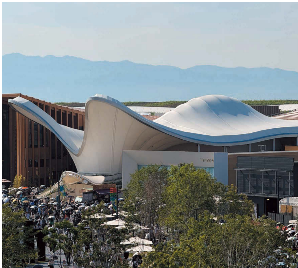
「砂漠を飛ぶ空飛ぶじゅうたん」のような、非常に柔らかく、流れるような美しい曲面デザインが特長のクウェートパビリオン。薄く、軽やかな素材で、厚みのない美しい形状を実現したいという強いコンセプトを実現するため、デザインの自由度に優れる膜構造が最適な選択肢として選ばれた。
