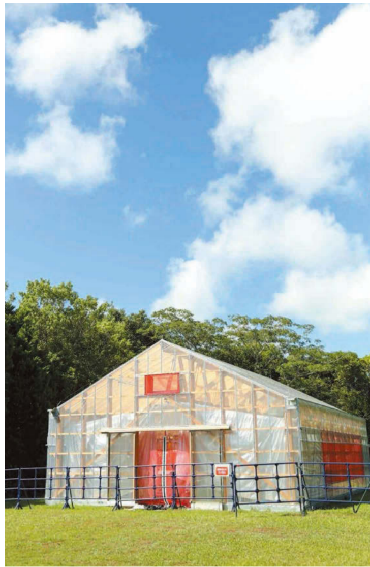
cultivera と XENCE がコラボして制作したサーキュラー木造温室。地域の未利用木材を元に開発したモジュールで作られており、地域の森林資源活性化や食糧自給率向上へ向けた試みでもある。 Photo by Morio - Skyscrapers of Shinjuku 2009 January.jpg / CC BY-SA 3.0
