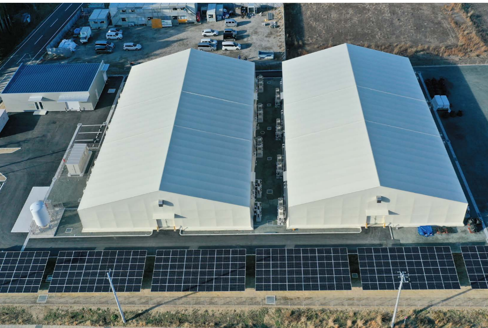
山口産業の新しい陸上養殖施設は、従来の鉄骨構造に代わる軽量で高耐久の膜構造を採用
