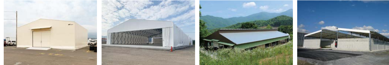
▲ テント倉庫 ▲ 伸縮式テント ▲ 膜構造畜舎 ▲ 膜構造堆肥舎
