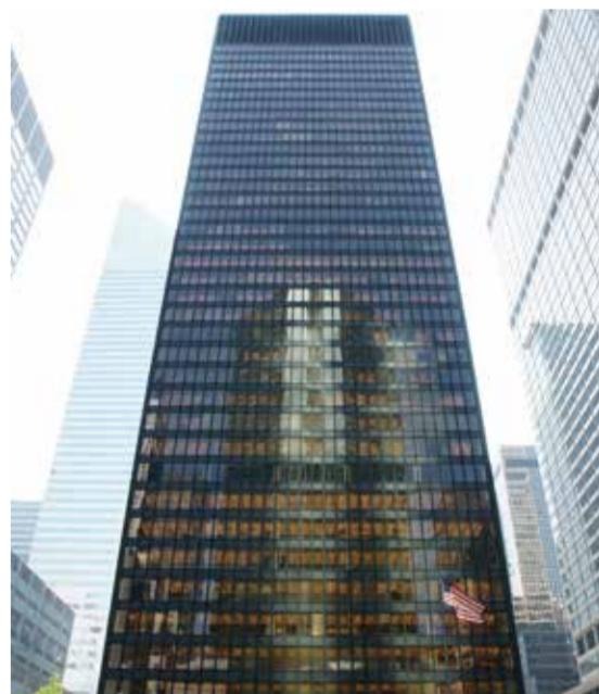
鉄骨とガラスのカーテンウォールで作られた、ニューヨークにある「シーグラム・ビルディング」。
